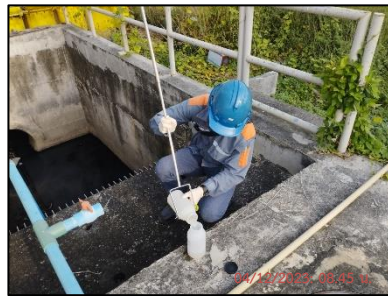
บ่อกักน้ำเสียก่อนเข้าระบบบำบัดน้ำเสียส่วนกลาง
